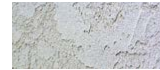
Restore Existing Stucco
